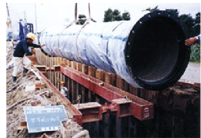
（配水管布設替え工事）
