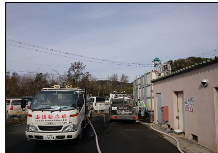
<受水槽への給水>
